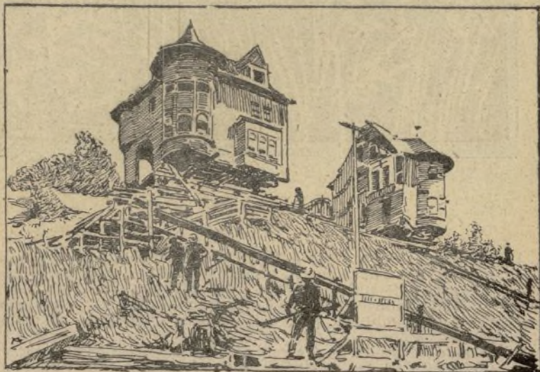
«VILLA WINNIPEG» EN CALIFORNIA PARTIDA EN DOS TROZOS PARA FACILITAR SU TRASLADO
