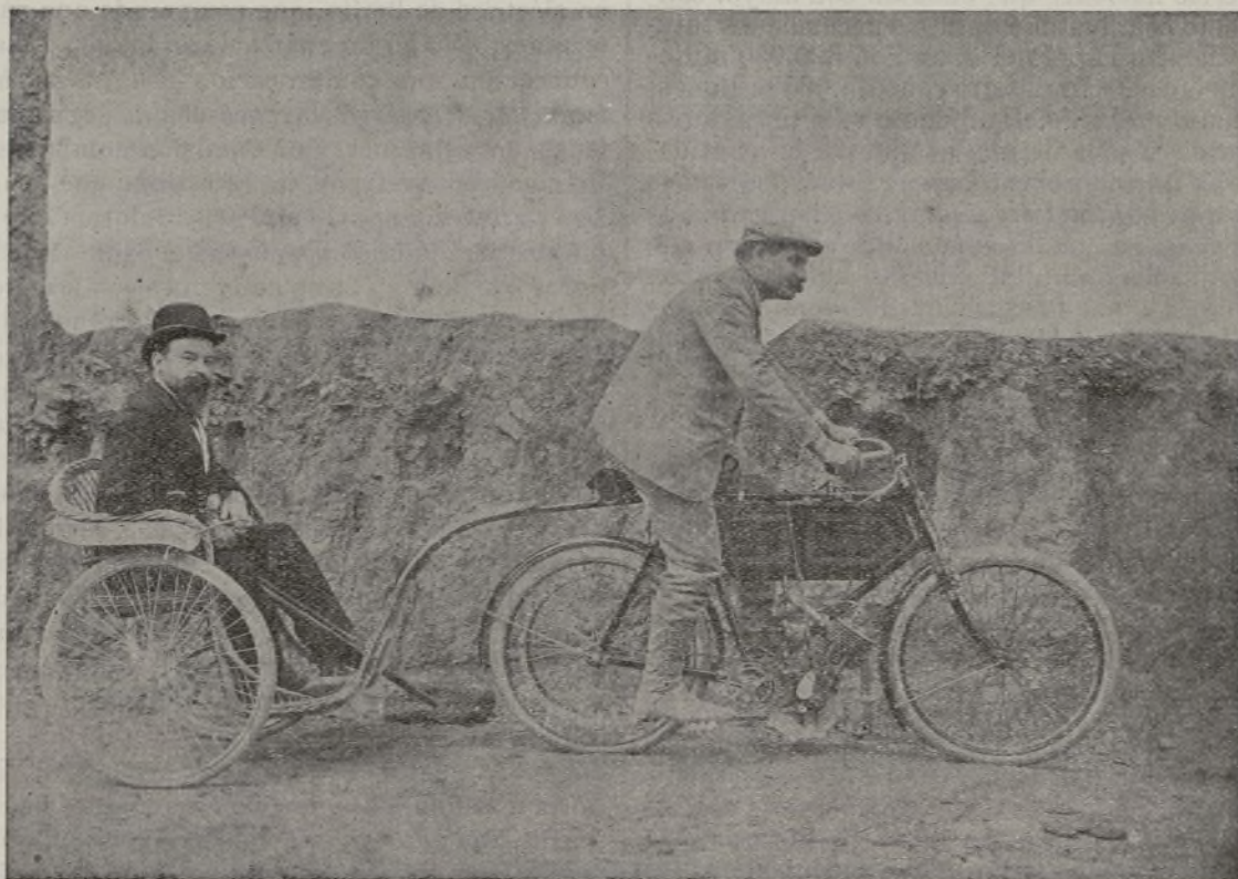
Motocicleta con motor de 3 1/2 HP. con voiturette á remolque
