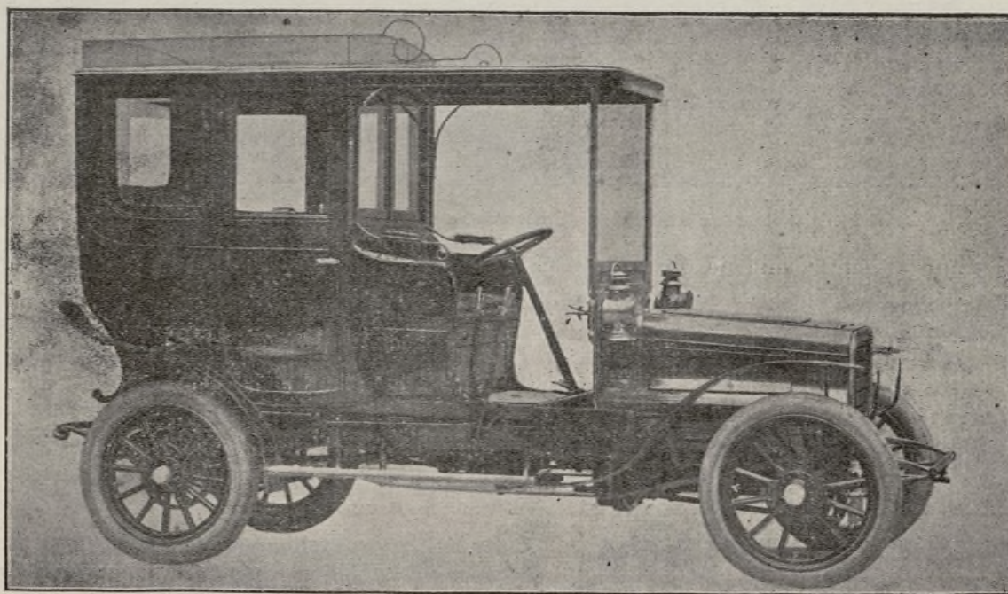
Tipo de coche de 4 cilindros de 12 y 16 HP. forma limousine de gran lujo desmontable
