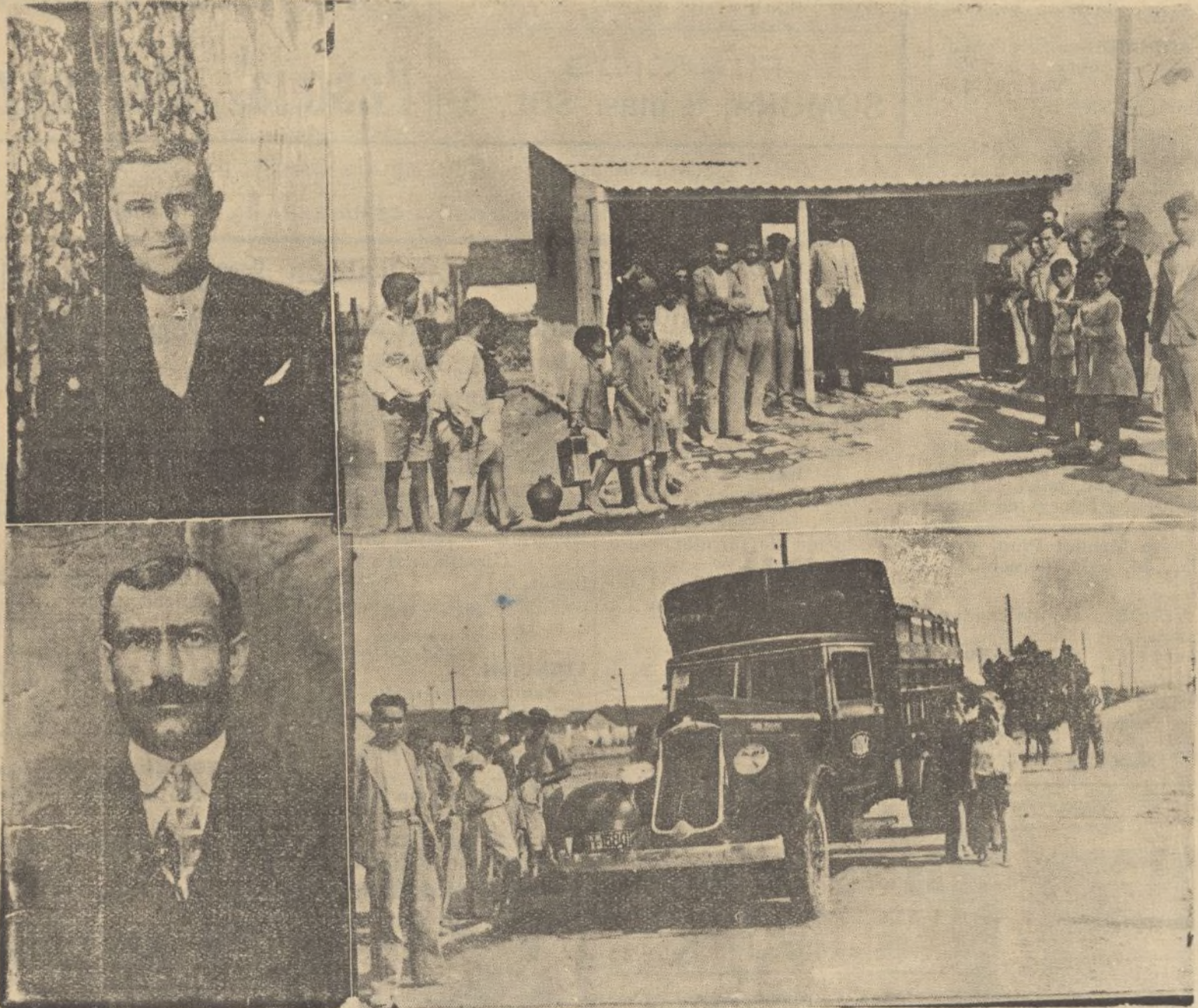
En la parte superior.—El fielato de Cardañas, frente al cual ocurrió el trágico accidente que reseñamos, y el desgraciado Juan Rebollo Rebollo que pereció en el mismo. En la inferior.—El camión causante de la desgracia, y otra de las víctimas, Juan Díaz Rodríguez, que se encuentra gravemente herido en el Hospital Provincial. Foto Baez.
