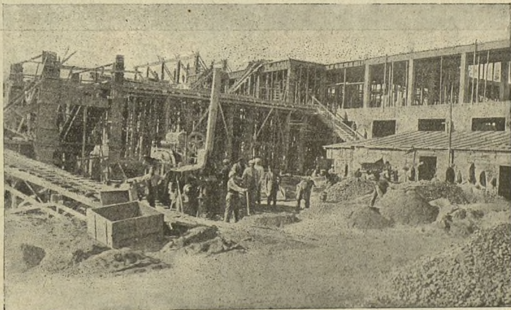
El nuevo Colegio de Huérfanos. Estado y construcción de la meseta central del edificio.
