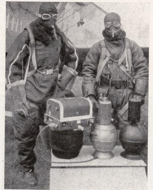
Piloto y fotógrafo con la Cámara aérea y el equipo de oxígeno para los vuelos a gran altura
