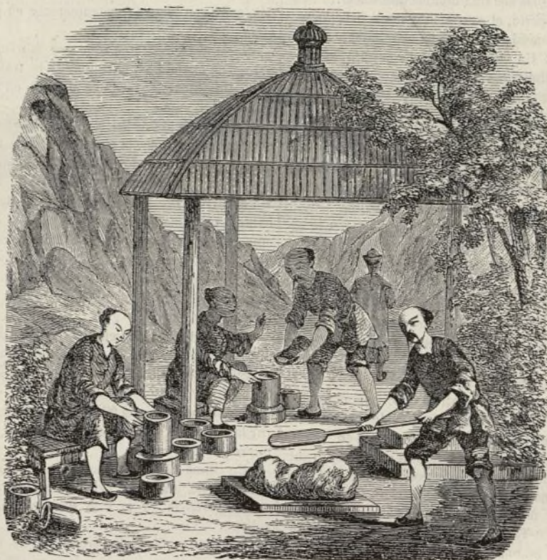
Fabricacion de los moldes.
