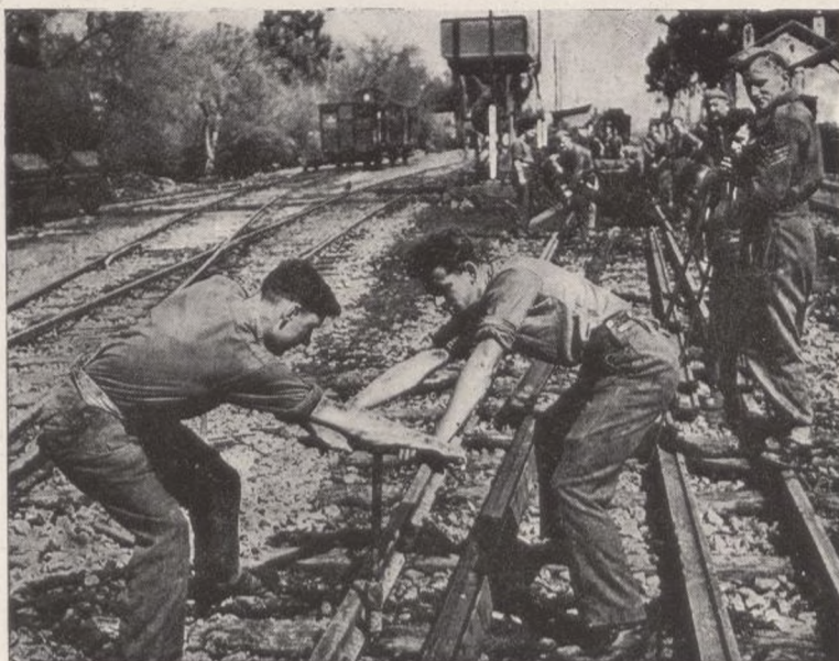
Soldados de Ingenieros británicos arreglando una línea férrea averiada, necesaria para llevar los pertrechos y suministros a la primera línea del frente en Túnez
