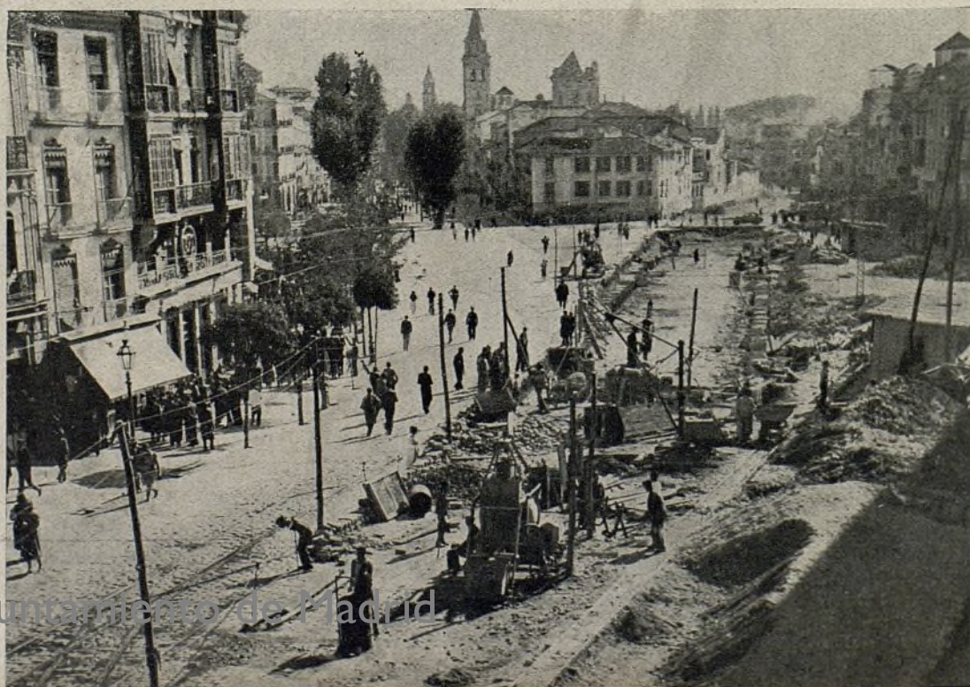
Vista general del embovedado durante la ejecución del segundo tramo de bóveda.
