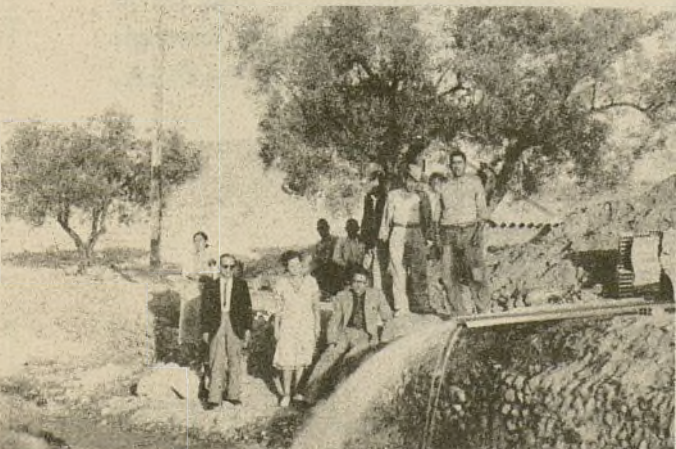
Yacimiento de agua potable núm. 4, propiedad del Ayuntamiento de Elche, construido en los primeros meses del Año de la Victoria. En la actualidad se obtiene ocho litros por segundo, calculando que se podrá obtener a su terminación unos veinte litros por segundo.
