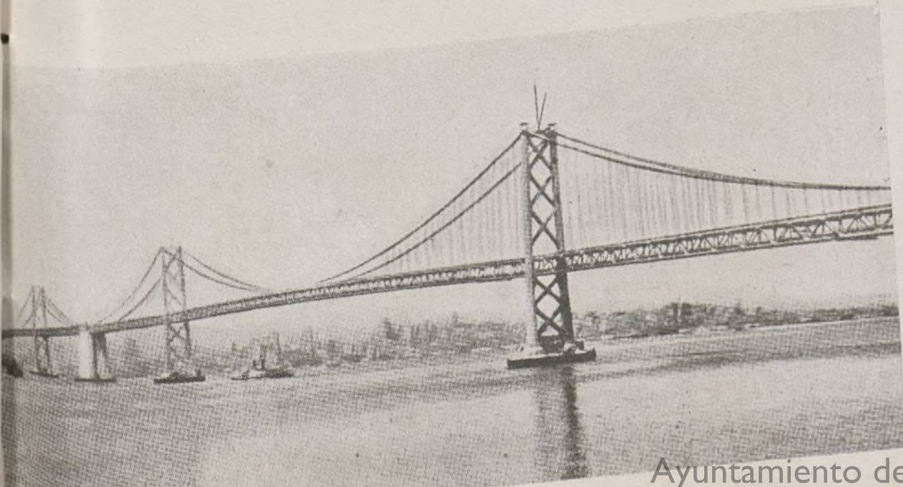
La sección occidental del puente, entre San Francisco y la isla de Yerba Buena, mide poco más de tres kilómetros de largo y se eleva lo suficiente para que pasen por debajo los grandes vapores. Nótese los dos pisos del puente: el superior para el tráfico liviano, el inferior para camiones y trenes eléctricos.
