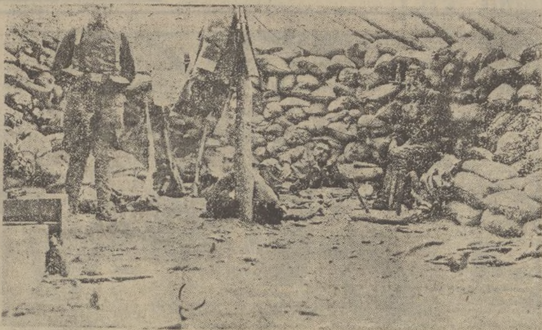
Interior de un reduto fortificado, tomado al enemigo, en el que pueden verse las troneras a través de los sacos terreros. Du ante el ataque perdió el ramaje que le cubría y disimulaba.
