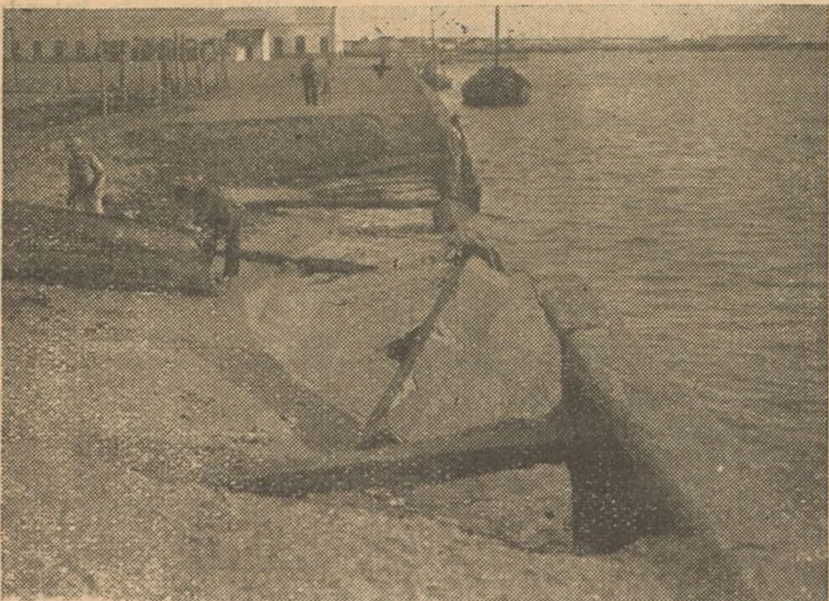
Estado de ruina en que se encuentra el muelle del relleno Sur de la población. En el sitio señalado con una X existe otro trozo en iguales condiciones que el que aparece en primer término
