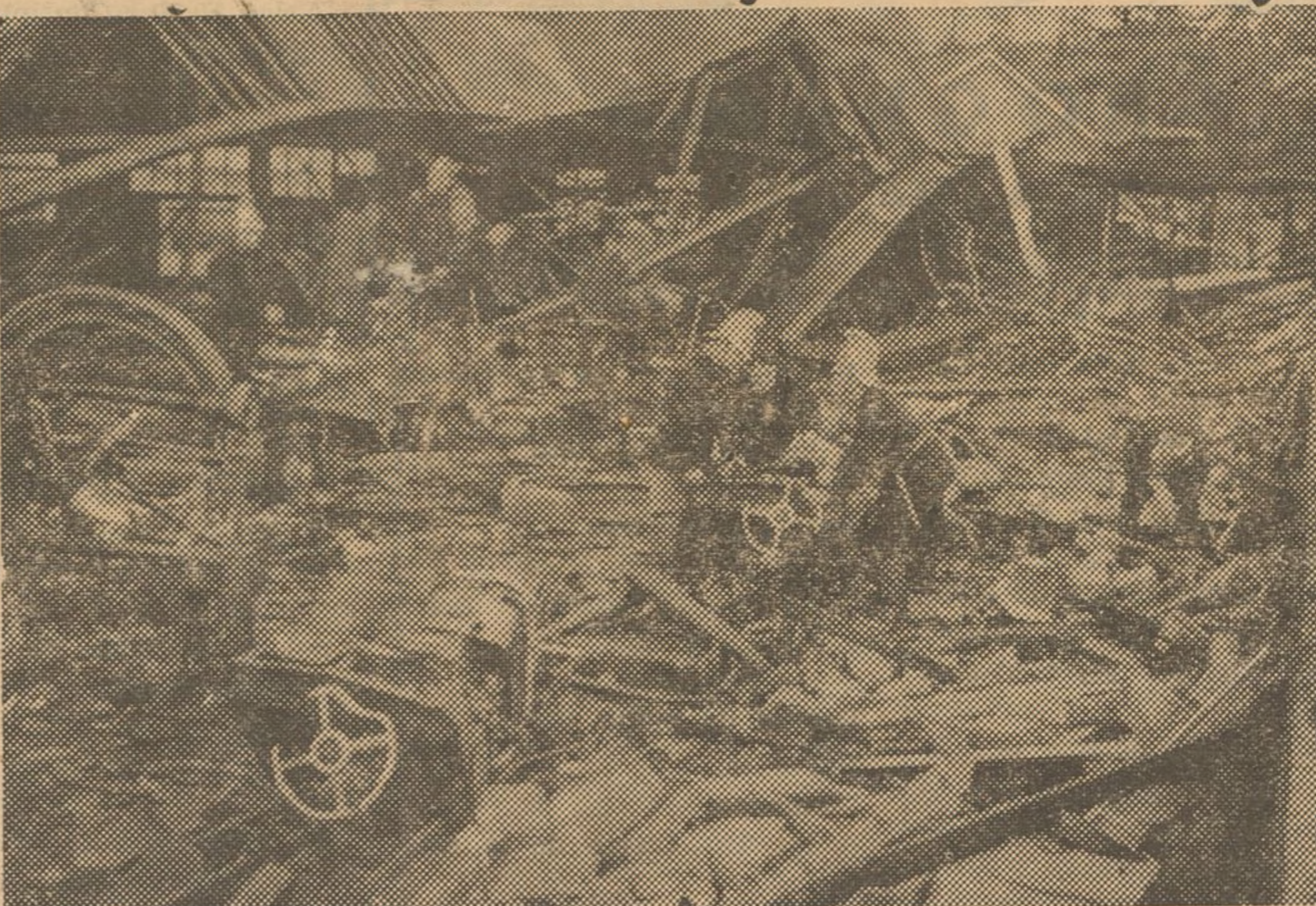
En un garage situado en Surrey (Inglaterra) se declaró un violento incendio quedando totalmente destruido, así como cincuenta automóviles. Durante la extinción del incendio resultaron varios bomberos heridos gravemente. Estado en que quedó el garage después del siniestro
