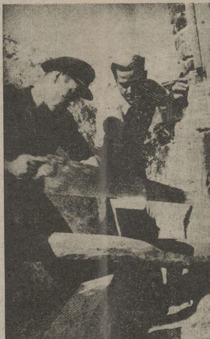
Para hacer frente al enemigo y al frío, hay que entibar y cubrir trincheras. Estos soldados de la Brigada trabajan afanosamente. Dentro de poco, la trinchera será un seguro refugio contra el invierno y la metralla enemiga.
