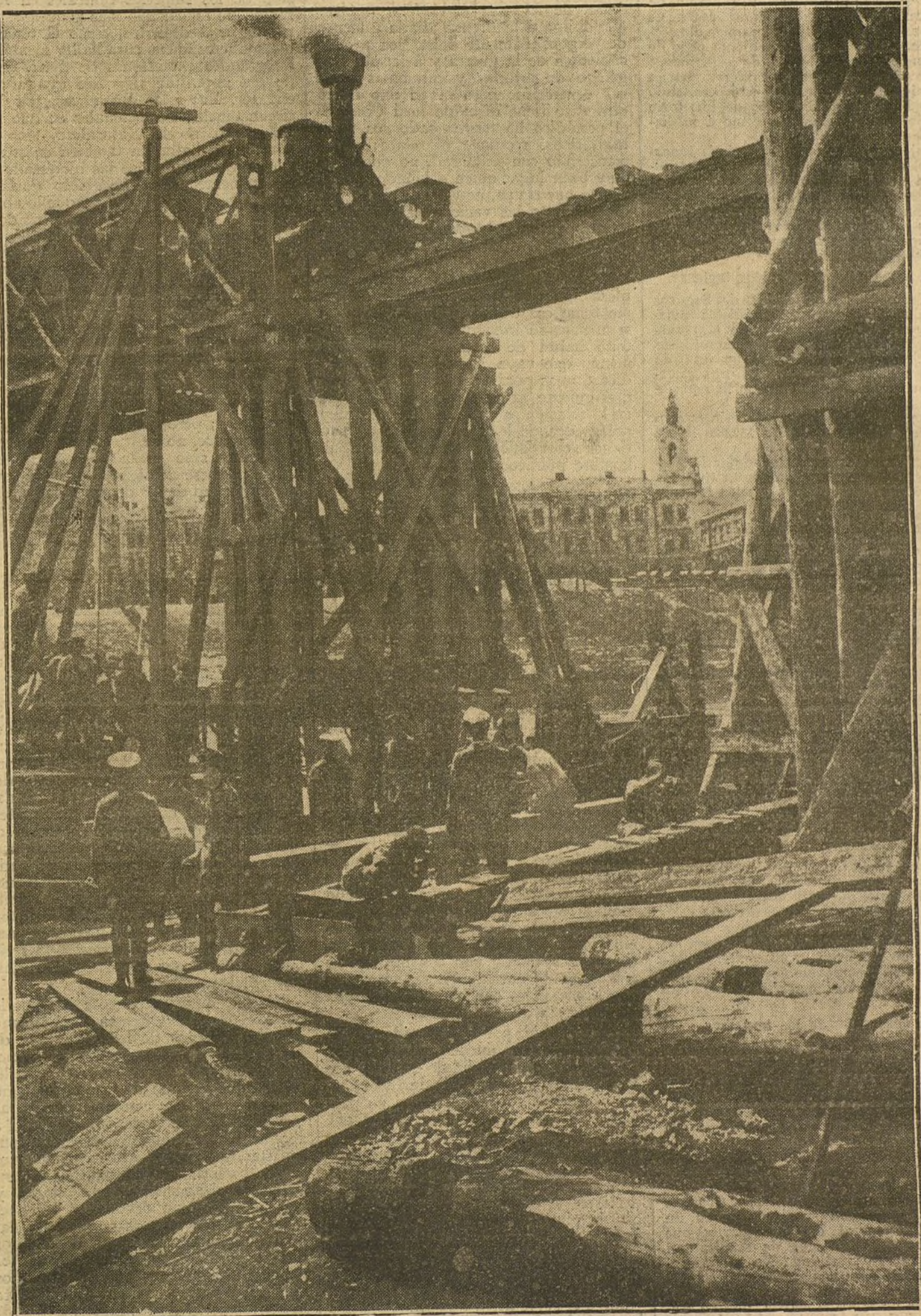
Ingenieros austriacos probando la resistencia de un puente provisional construido sobre otro volado por los rusos. (Fotografía «Hamburger-Fremdenblatt».)
