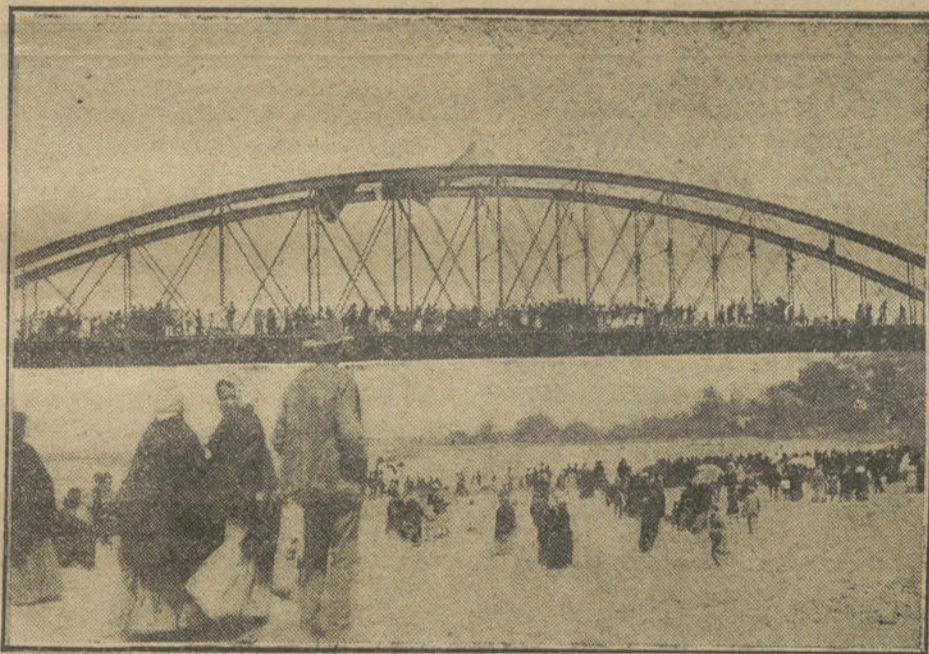
CUEVAS (Almería).—Puente metálico del Almanzora, recientemente inaugurado, el cual mide 250 metros de longitud, siendo de los mayores de las carreteras de España (Fot. F. de BLAIN.)
