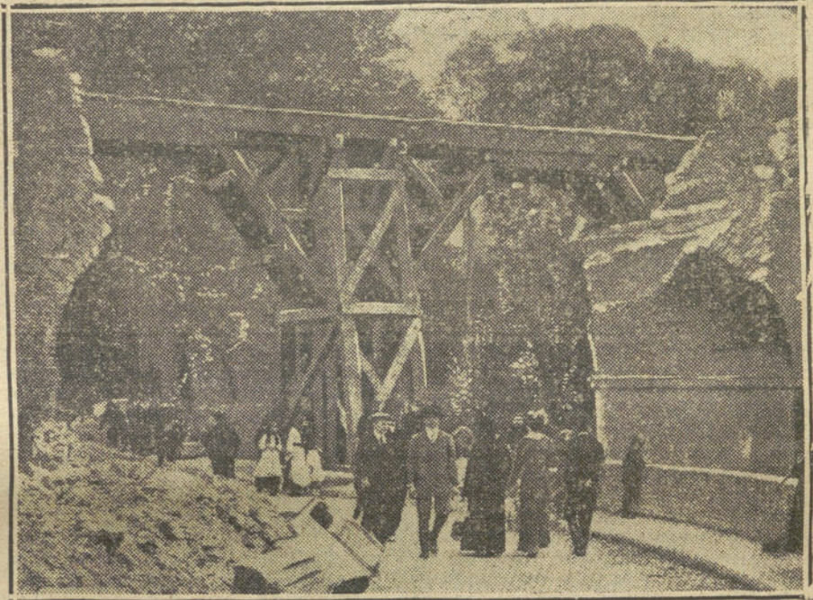
LA GUERRA EN BELGICA.—Puente provisional construido por los alemanes sobre las ruinas de otro destruido por los belgas en su huida.
