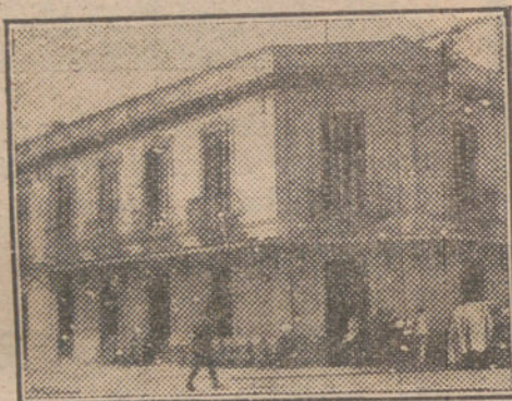
Vista exterior del edificio que ocupa el Círculo Mercantil.
