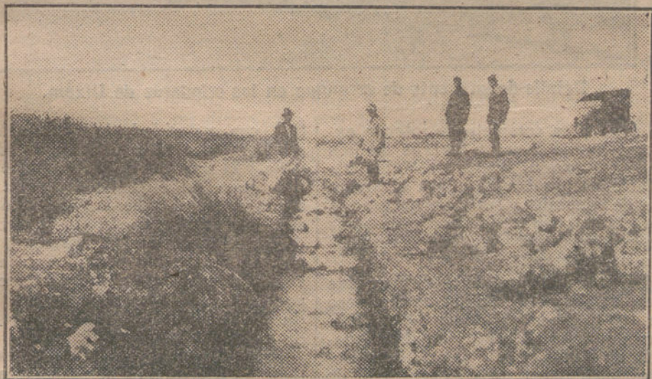
Canal construido por la Compañía Española de Colonización en Monte Arruit y nacimiento de Tigant.
