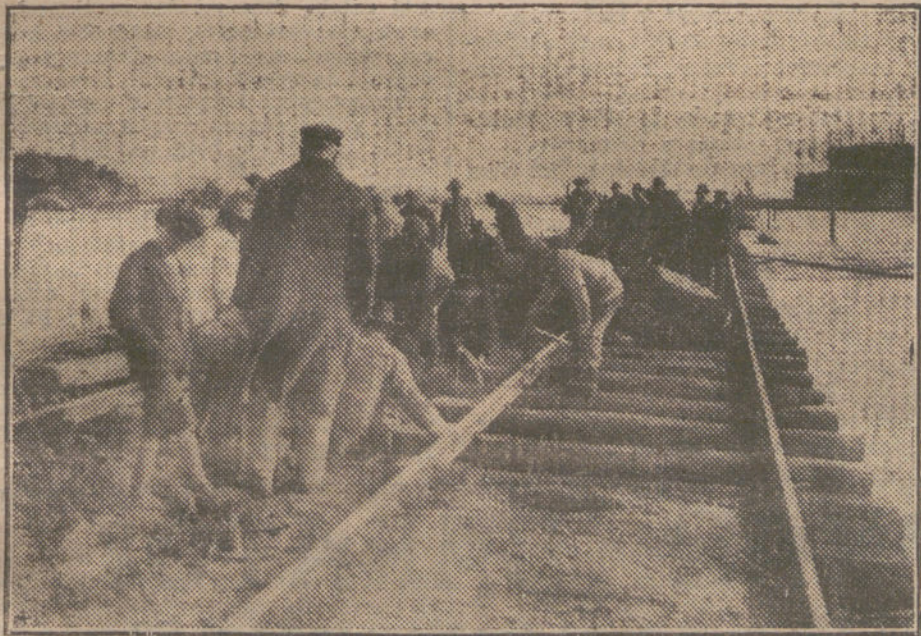
LA INUNDACION DE SEVILLA.—Los obreros de los ferrocarriles andaluces reparando la vía de Cádiz a Granada, que fue arrastrada por las aguas en los pasados temporales. (Fot. OLMEDO.)
