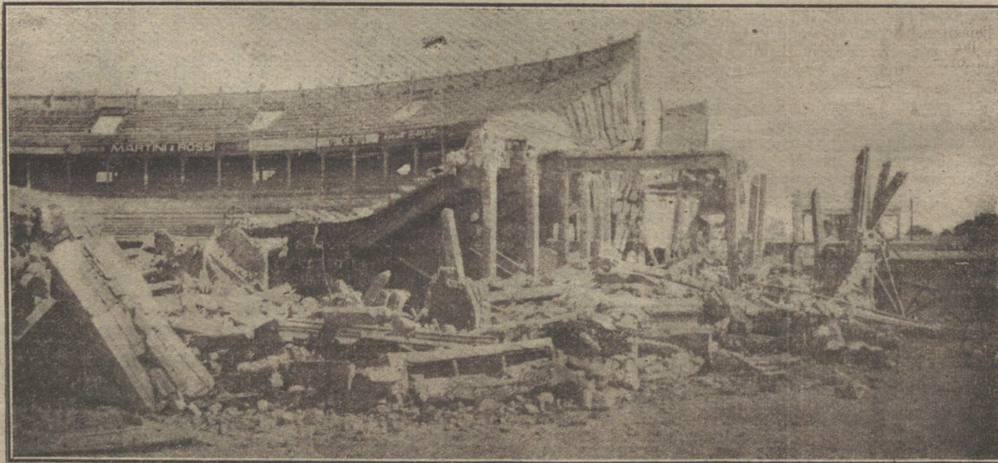
Estado en que quedó la Plaza Monumental de Sevilla, después del hundimiento, ocurrido en ocasión de hacerse las pruebas de resistencia. (Fot. OLMEDO)
