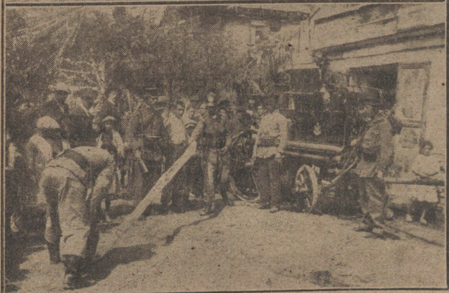
EL TEMPORAL EN MADRID. —I. Casas de la calle de Pignatelli, en las Ventas, desalojadas por los vecinos.—II. Bomberos trabajando en el desahogo de unas casas de las Ventas. (Fot. VIDAL.)
