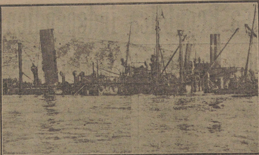
COMO PONE A FLOTE EL ALMIRANTAZGO INGLES LOS BARCOS TORPEDEADOS.—Fotografías en las que se ven los trabajos que realizan los numerosos equipos de buzos y mecánicos para salvar la flota hundida. Hasta Mayo de 1918 el número de barcos recuperados por este medio ascendían a 400. Hoy ese número se ha duplicado.
