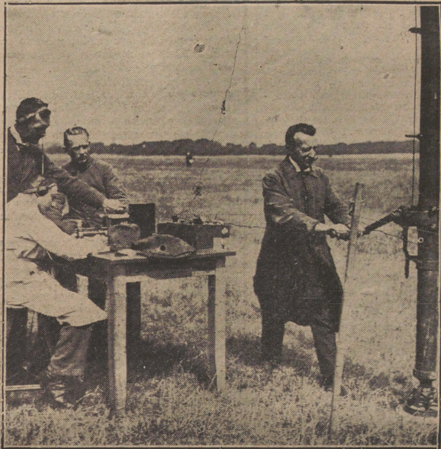
LOS GRANDES INVENTOS.—Aparato de telefonía sin hilos, que alcanza la voz á distancias hasta de 150 kilómetros. Afortunadas pruebas, verificadas en Berlín. (Fotografía SENNECKE.)
