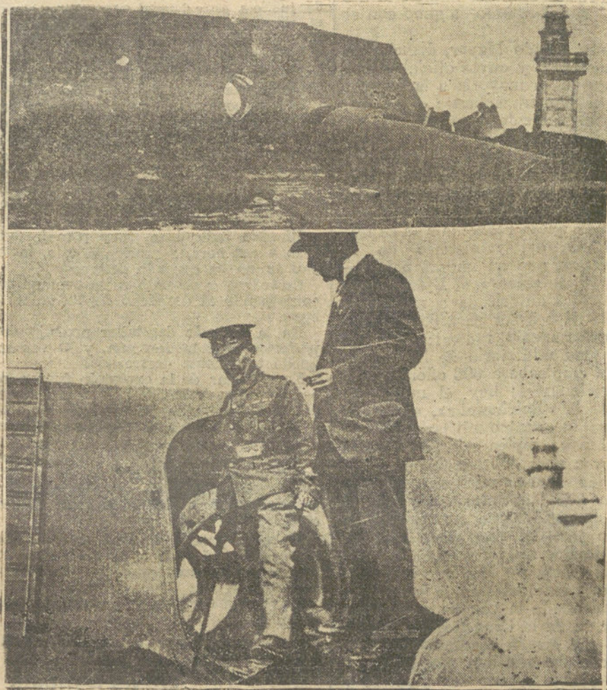
LOS GRANDES CAÑONES DE MARINA DE LA ISLA DE HELIGOLAND, SECCIONADOS CON LAMPARA OXIDRICA, PARA INUTILIZARLOS. EL MAYOR INGLÉS, JAMES Y EL INGENIERO ALEMÁN PLATZ, INSPECCIONANDO LOS TRABAJOS DE DESARME EN HELIGOLAND.
