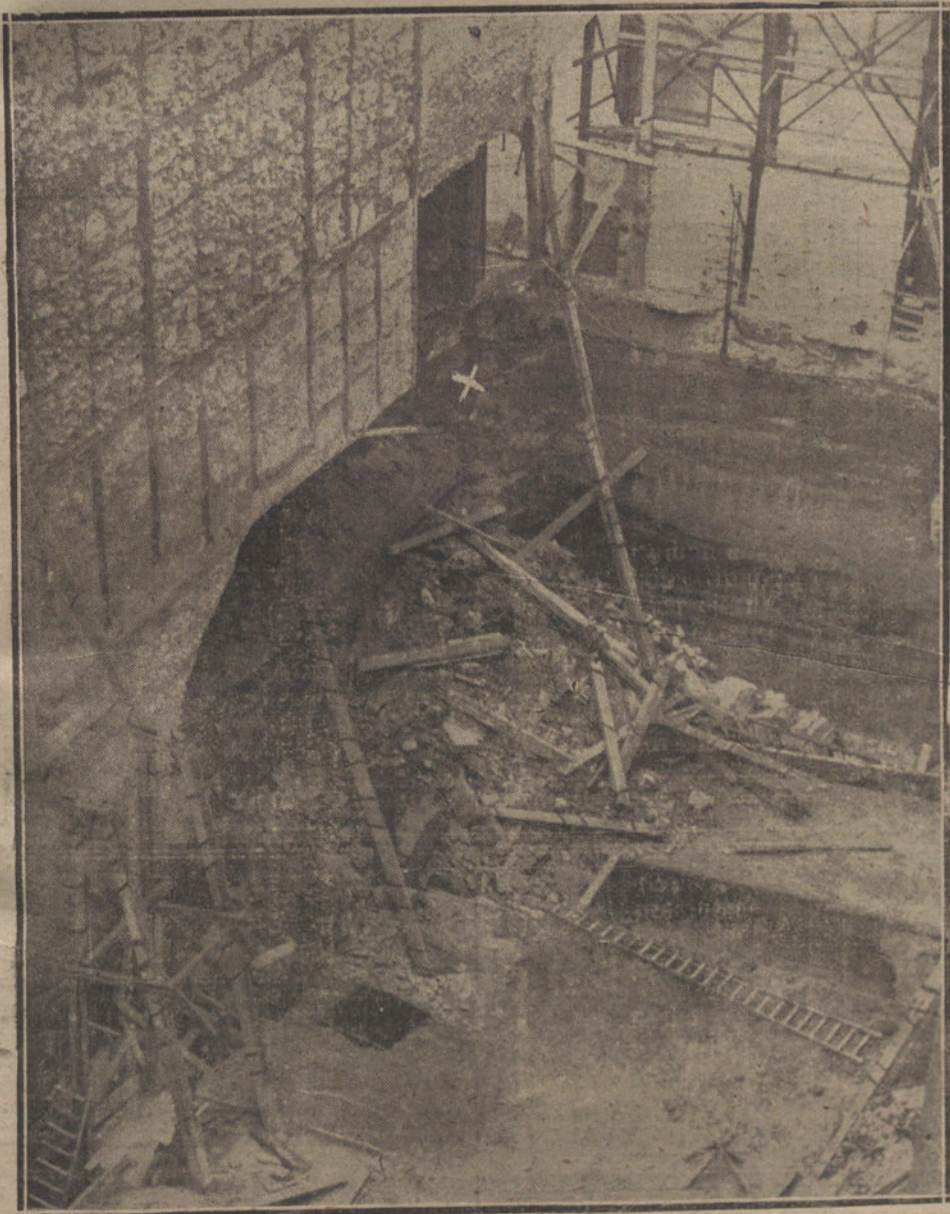
EL HUNDIMIENTO DEL LYON D'OR.—Boquete abierto en la medianería del café, y que fué la causa del suceso. (Fot. VIDAL)
