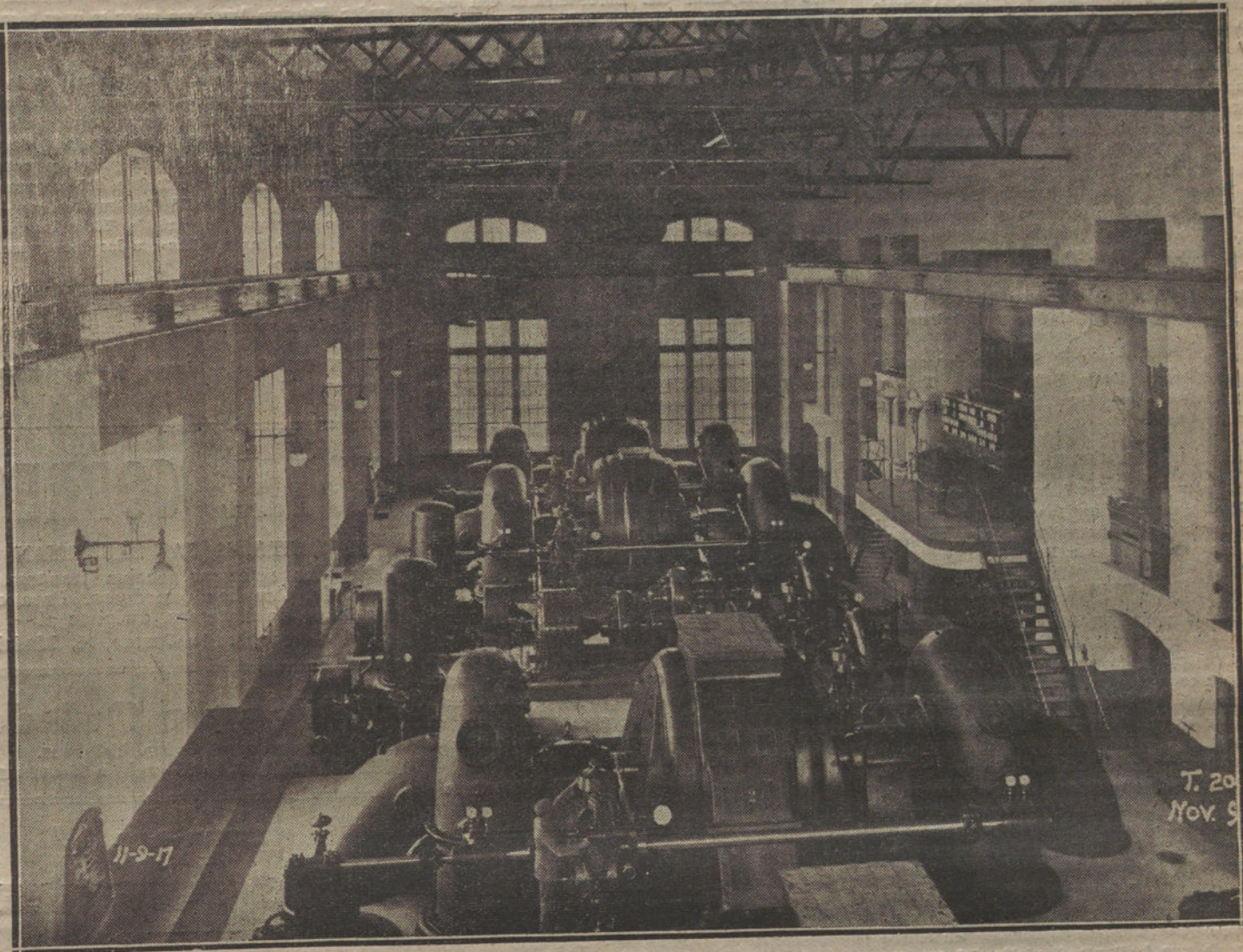
Gran sala de máquinas de la Central de Tremp, cuya capacidad es de 36.000 HP.
