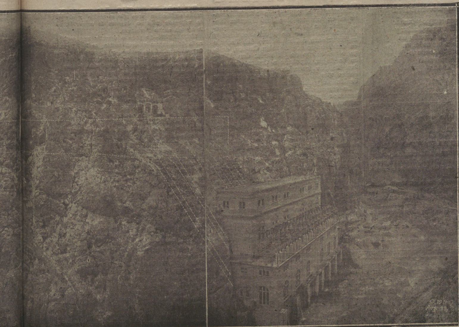
Central de Tremp, que actualmente produce 37.000 HP., es capaz para una producción total de 92.000 HP., estando construida a dicho efecto.
