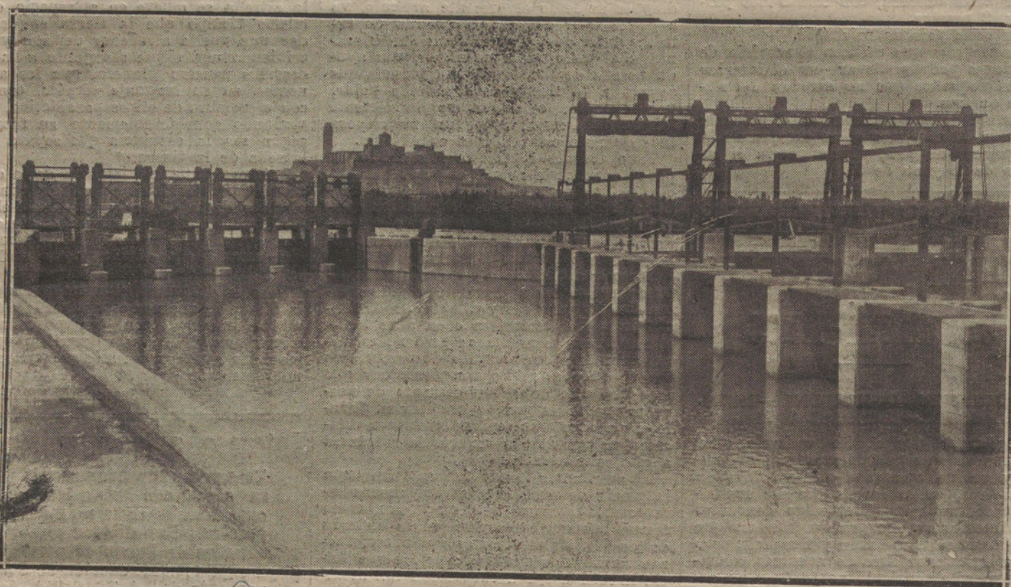
Vista de la toma de agua en Lérida del canal industrial que suministra a la Central de Serós, distante 23 kilómetros, el caudal de agua para la producción de 56.000 HP.
