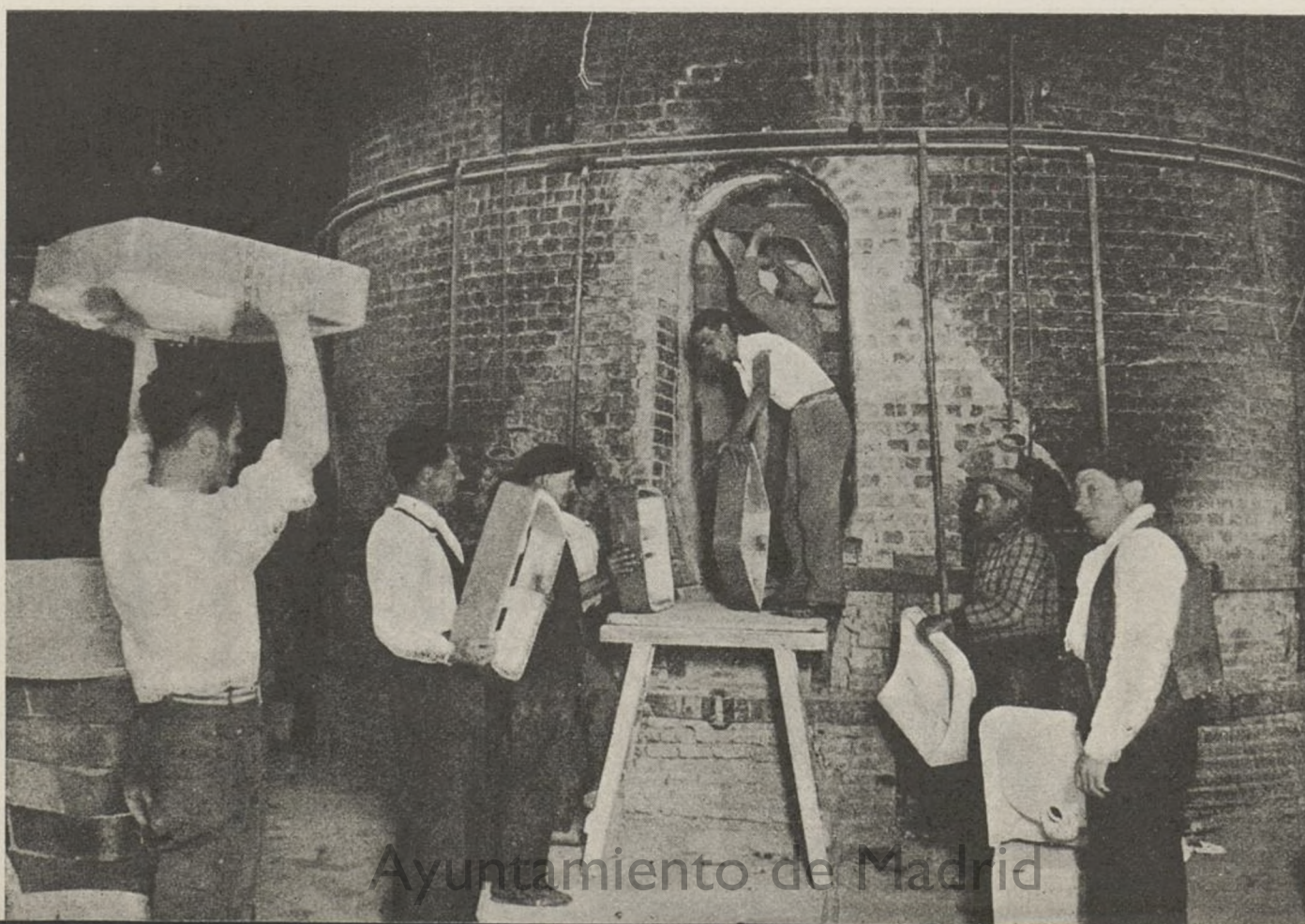
LA COLECTIVIDAD INDUSTRIA DEL SANEAMIENTO, INSTALADA EN LA CARRETERA DEL PORT.—Obreros llenando los grandes hornos, de loza. Una de las operaciones más importantes que se realizan en la industria.
