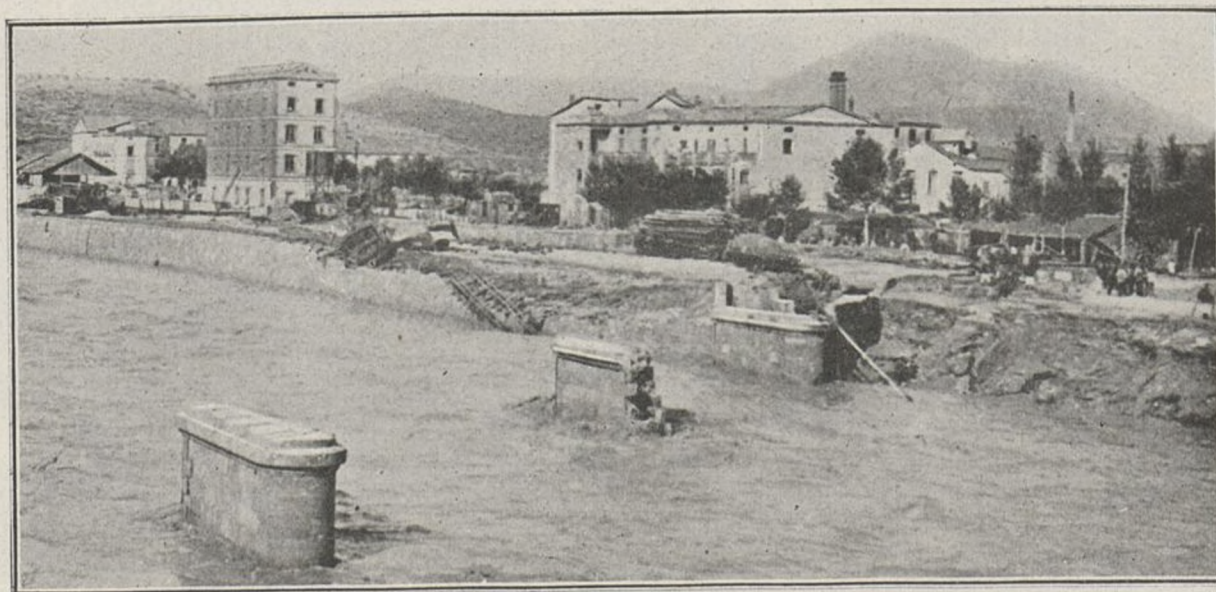
Puente y estación del ferrocarril de Manresa á Berga, destruído por la inundación.
