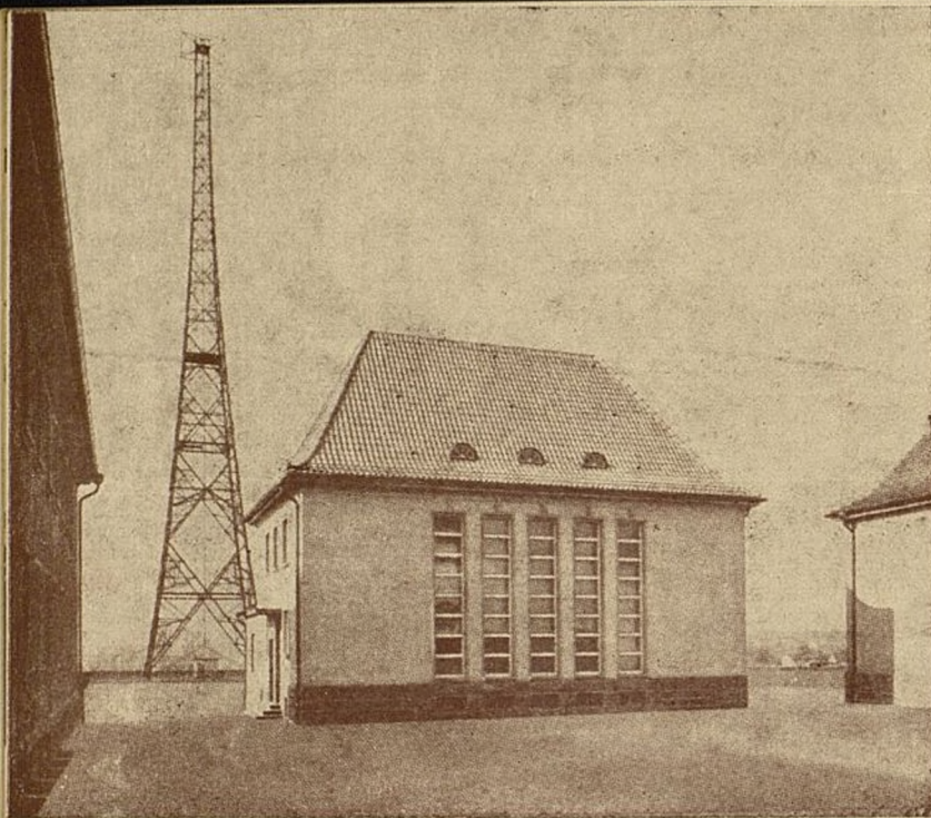
Emisora de radio- difusión alemana con antena vertical para evitar el des- vanecimiento (fa- ding) en los recep- tores
