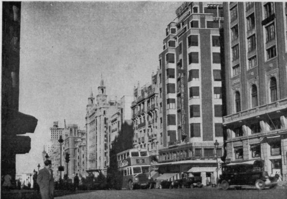
Vista general de edificios en la acera de los pares del tercer trozo.
