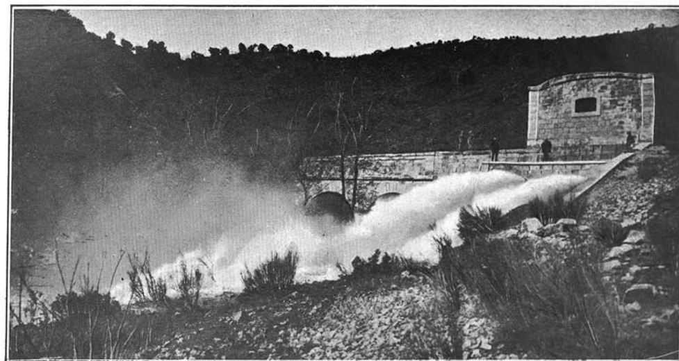
Fig. 16.—Sifón del Guadalix. —Desagüe de fondo.
