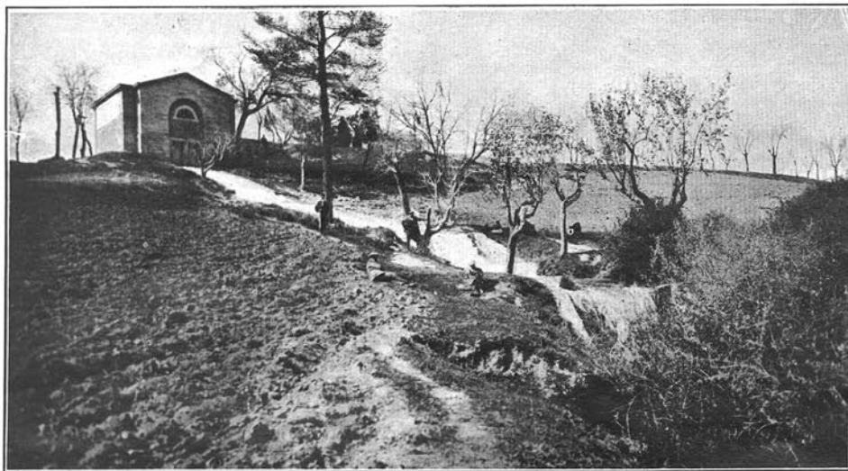
Fig. 24.—Desagüe de la cámara de entrada de aguas al sifón del Bodonal.
