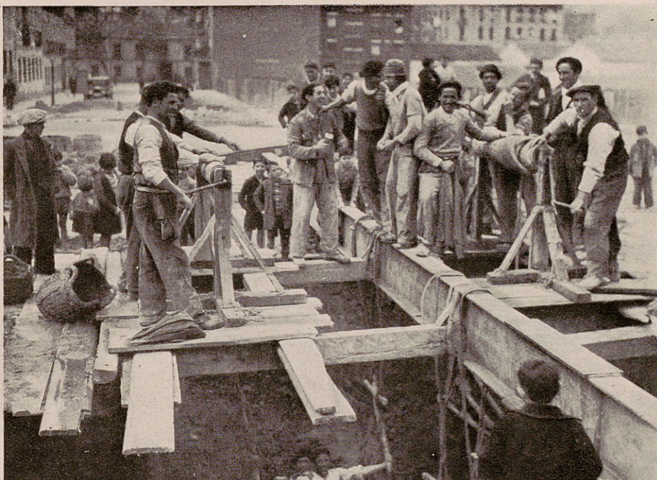
Aun en los días más críticos para el Madrid heroico, amenazado por el fascismo, y que ya pasaron para siempre, Canales del Lozoya con sus obreros y su personal técnico no interrumpen su trabajo. Y vedlos aquí reparando una tubería rota por la aviación enemiga en la glorieta del General Álvarez de Castro y hormigonando en las proximidades de Chamartín de la Rosa el nuevo acueducto del Canal del Este, en construcción
