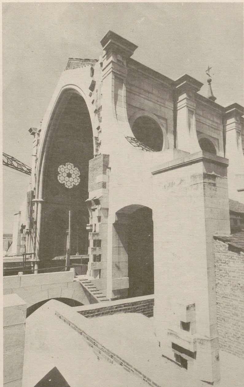
FIG. 21.— Contrafuertes de la nave mayor.
