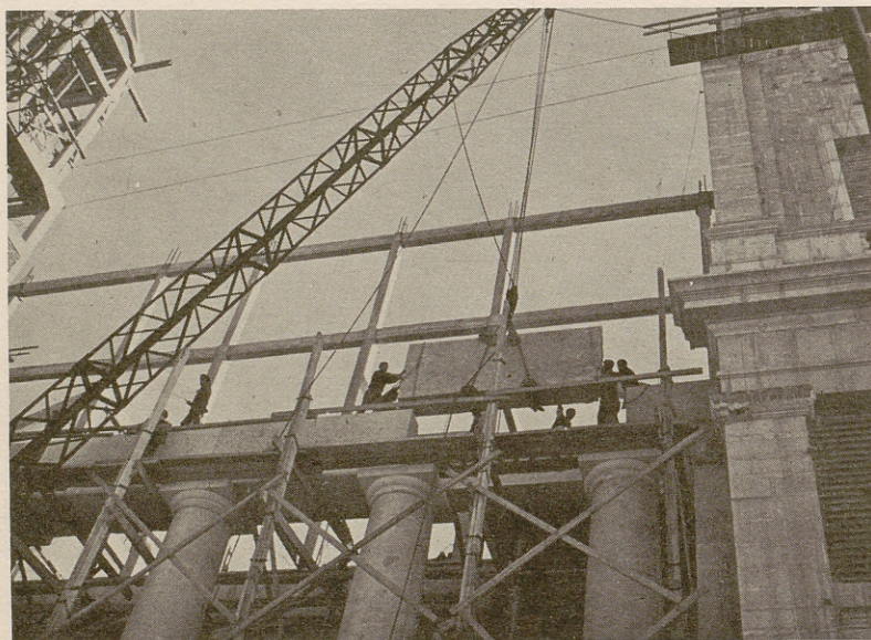
FIG. 20.—Colocación de un dintel de la fachada principal en el curso de las obras.
