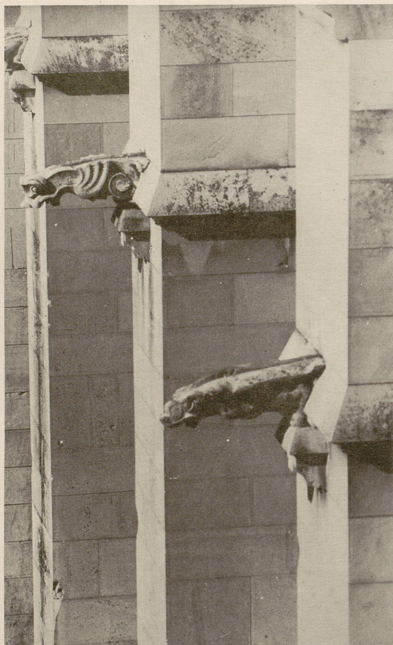
FIG. 14.— Contrafuertes y gárgolas.
