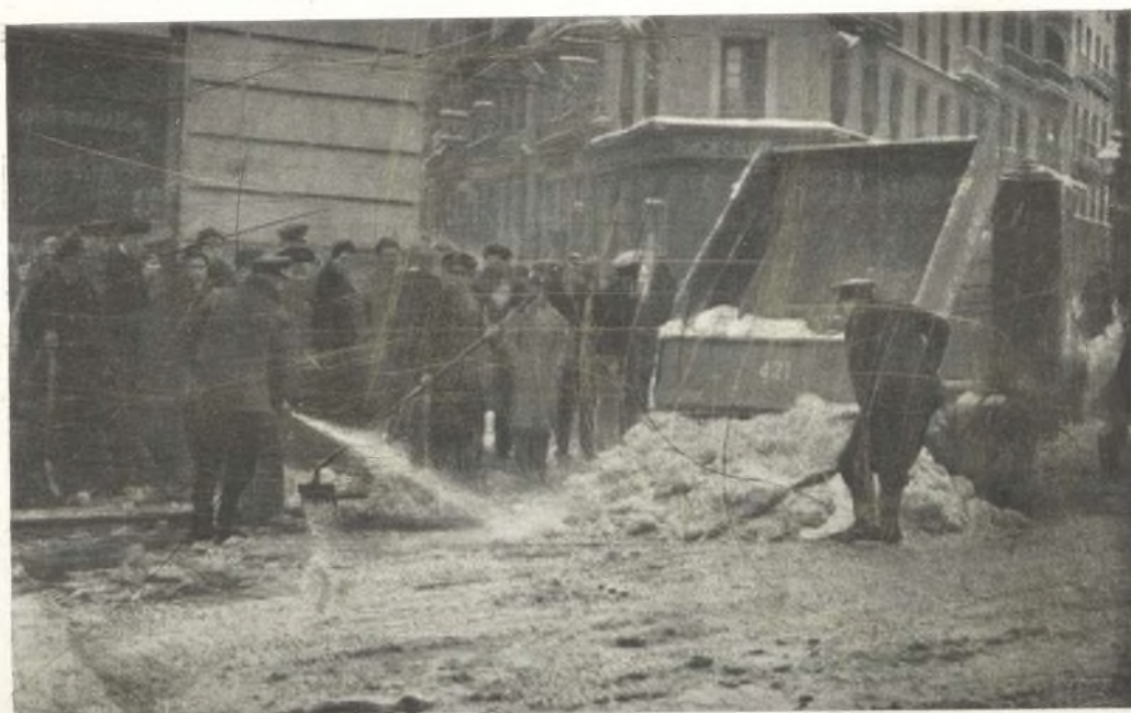
Figura 13.—Descarga de camiones en el traganieves de la Puerta del Sol.
