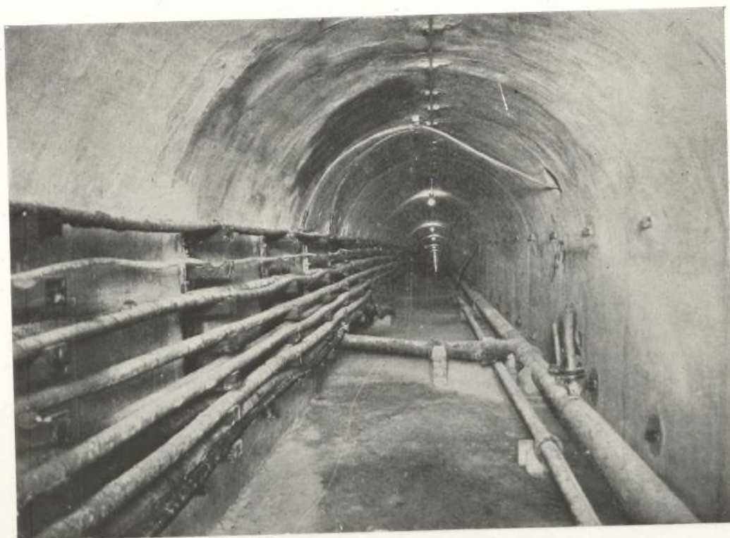
Figura 4.—Galería de la calle de Bárbara de Braganza. Vista general con servicios.
