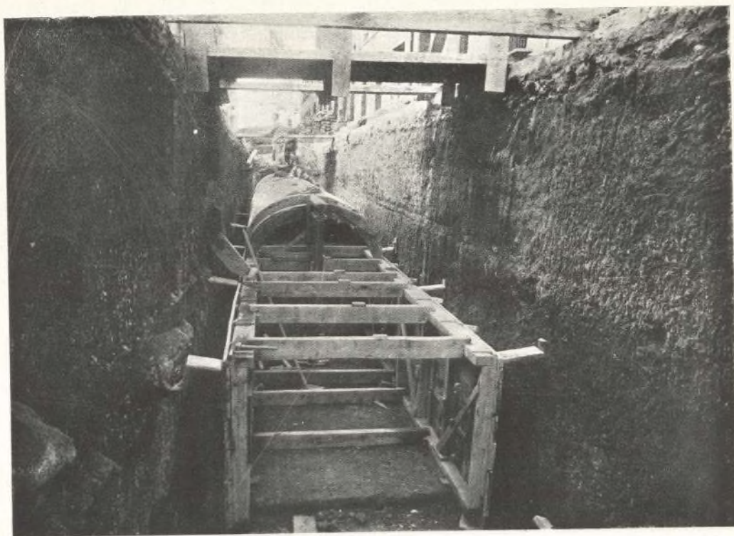
Figura 5.—Galería del paseo de las Delicias. Encofrado preparado para hormigonar un trozo de galería tipo B.
