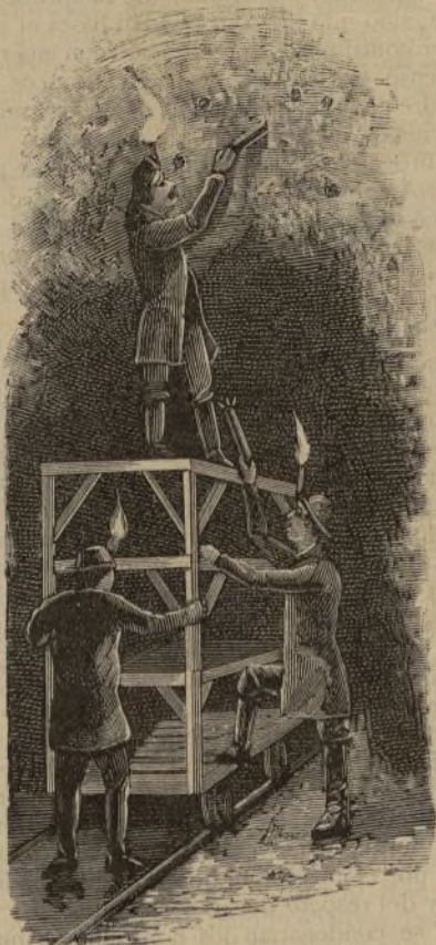
Colocación de los cartuchos de dinamita.
