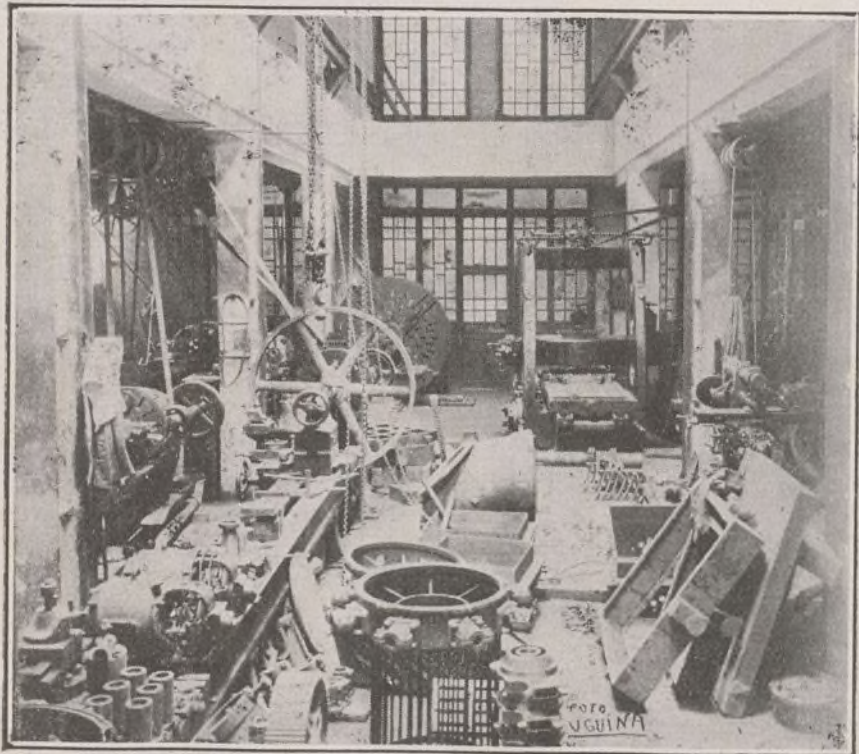
Un detalle del taller mecánico. Entre este taller y los demás, que componen el total de instalaciones de Talleres Iglesias, S. A., se encuentran reunidos los más modernos «spécimens» de la industria metalúrgica. Taladros, tornos, martillos de forja, fresadoras, tornos revolver, cepilladoras, máquinas de limar, componen el utillaje perfectísimo de esta fundición española.
