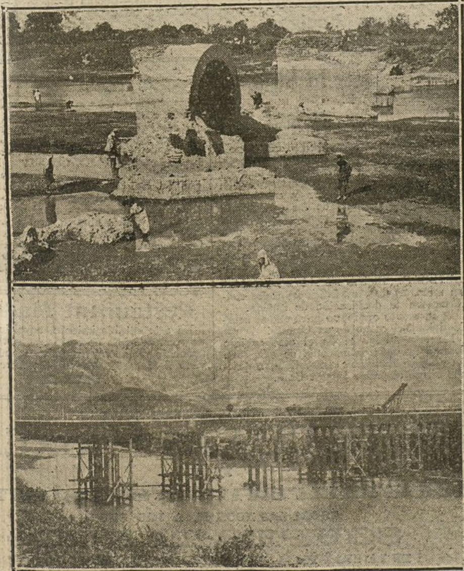
EN EL CAMPO DE TETUAN.—Puente del M'janiz, construido por los moros y deshecho por las crecidas del río Martín.—Puente construido por los ingenieros españoles sobre el río Martín. (Fot. LAZARO.)
