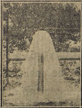
POZO ARTESIANO.—Rendimiento de este pozo: 3.000 litros por minuto.
