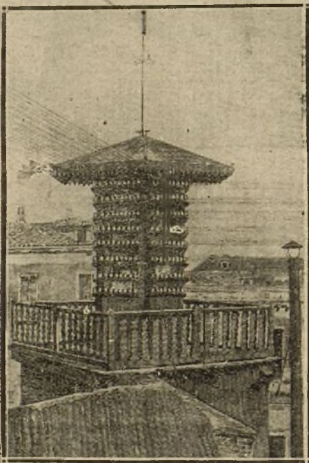
LA LINTERNA O CRUCE DE ALAMBRES EN EL TEJADO DE LA OFICINA CENTRAL (ANTANIO EN EL EDIFICIO MISMO DE TELEGRAFOS)
