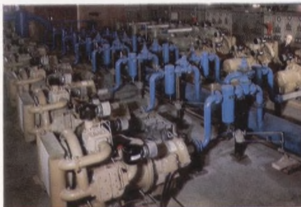
Druckluftzentrale mit 24 FMA-Kompressoren für eine U-Bahn-Baustelle in Brüssel
