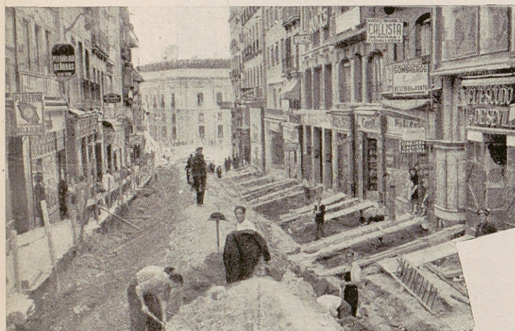
Fig. 13. — Obras de la galería de servicios en la calle de la Montera.
