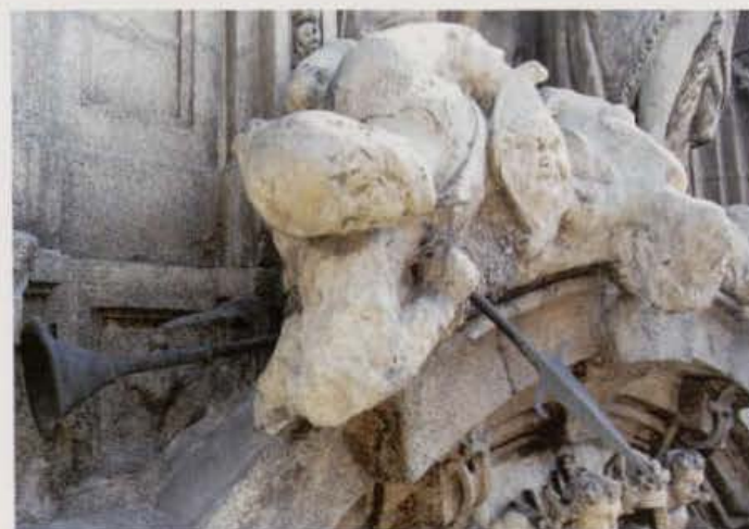
Limpieza con láser y reposición de elementos metálicos.
