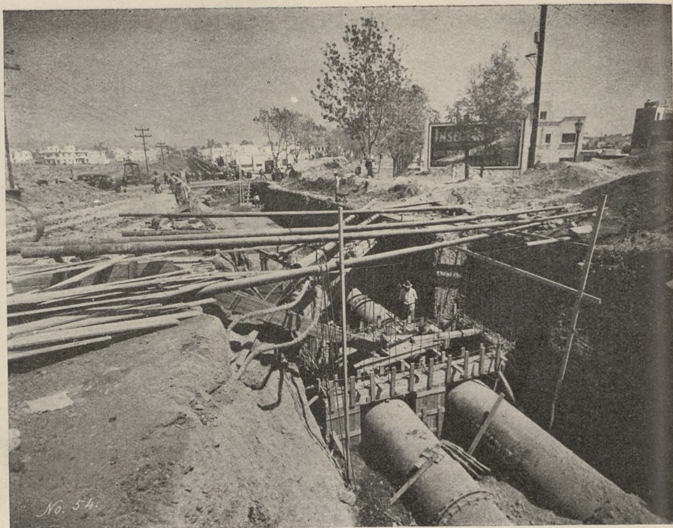
TENDIDO DE LA TUBERIA PARA LA REPOSICION DEL ACUEDUCTO DE XOCHIMILCO
