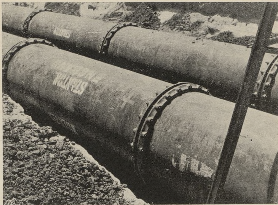
TUBOS Y JUNTA GIBAUT PARA EL NUEVO ACUEDUCTO COLOCADOS EN EL TRAMO NORTE DEL RIO DE LA PIEDAD
