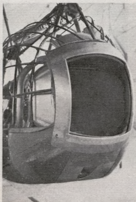
La refrigeración de los motores del Zeppelin: Ventanillas que abren ó cierran la entrada de aire á los radiadores
