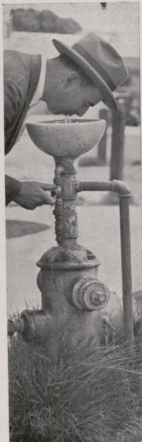
EJEMPLOS.—He aquí el que dan las autoridades de Torrance (California), haciendo adaptar á las bocas de incendio este dispositivo, que permite á los transeúntes beber, graduando el chorro de un pequeño surtidor (Fot. Ortiz)
