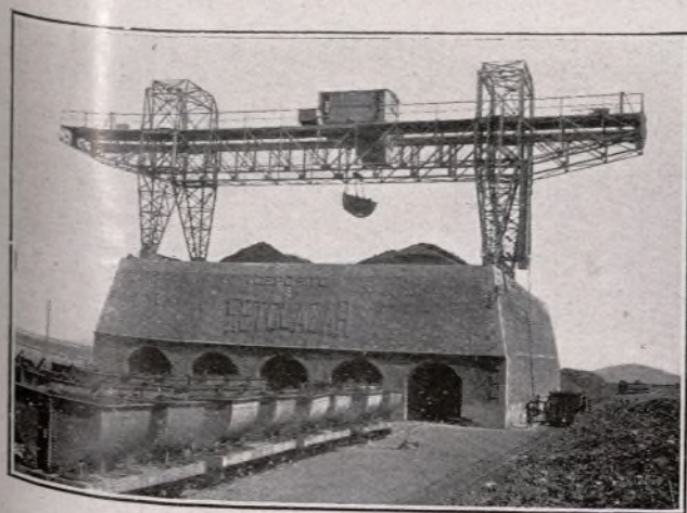
Grúa-puente y depósito elevado de minerales en la estación «Setolazar»
