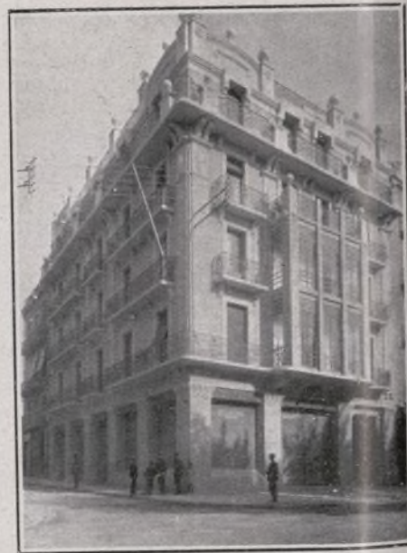
Edificio de construcción mixta, hormigón armado y trabajo corriente Contratista: D. José Icart
