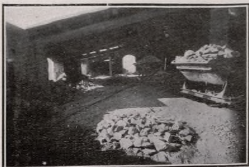
Fábrica de Cementos y Cal hidráulica.—Sección superior de los hornos (x) para la cocción de la piedra
