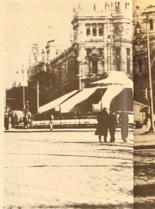
Protección de la Fuente de la Cibeles (Cat. 47)
