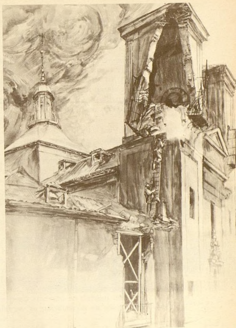
Destrozos en la iglesia de San Martín (Cat. 904)
