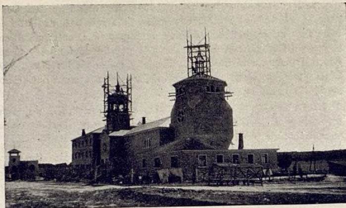
Colegio de María Auxiliadora. Arquitecto: José L. Oriol.
