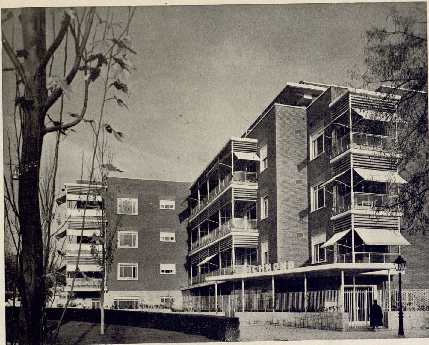
Edificio Richmond. Arquitecto, L. Gutiérrez Soto.
